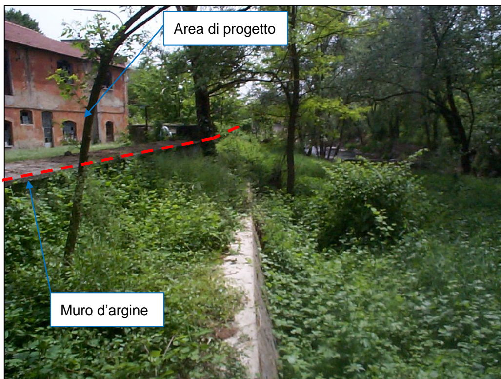
FOTO 7 – Particolare muro d'argine in sponda sinistra presso area di progetto (tratto con muro su due livelli).
