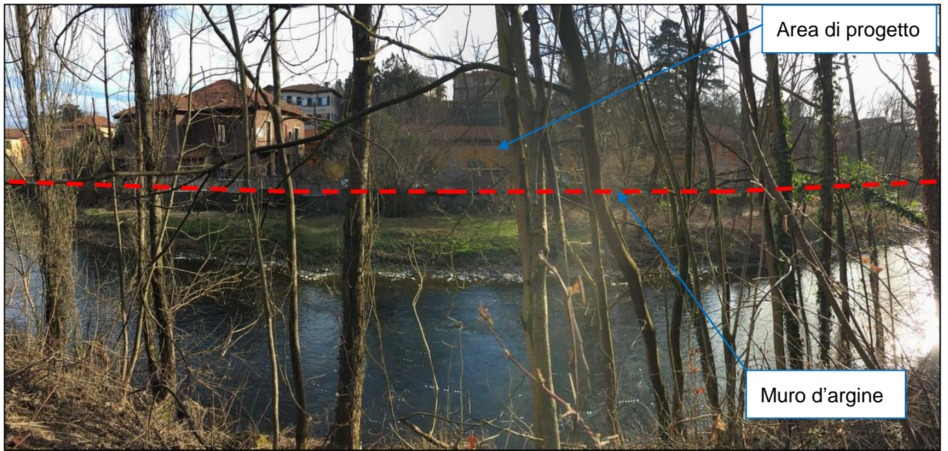
FOTO 5 – Continuità dell'argine a difesa dell'area di progetto in sponda sinistra.
