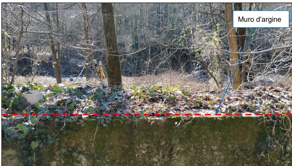
FOTO 12 – Particolare del muro d'argine durante le fasi di rilievo.
