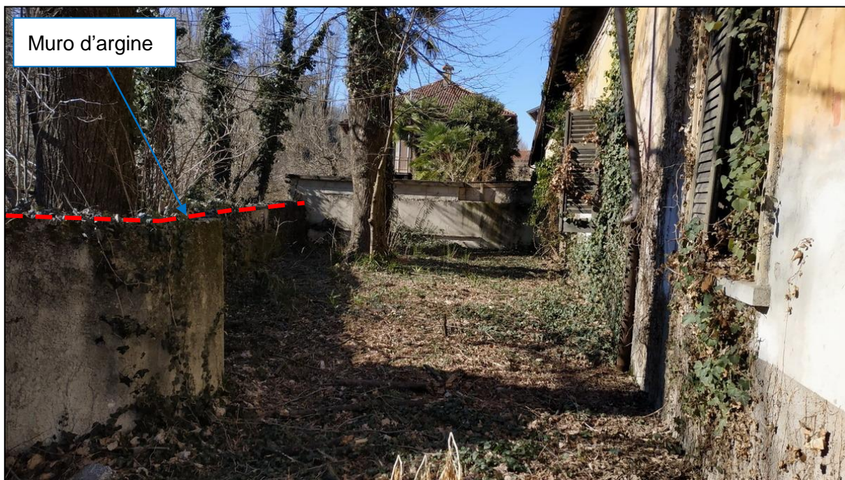
FOTO 11 – Area di progetto –porzione nord- con arginatura continua in sponda sinistra.
