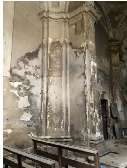
Parete zona altare
