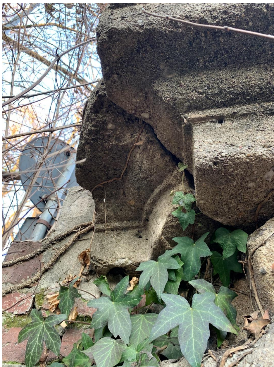
Figura 18 – Accostamento dei conci in Ceppo con giunto in calce e sabbia “invisibile”, sottolivello
