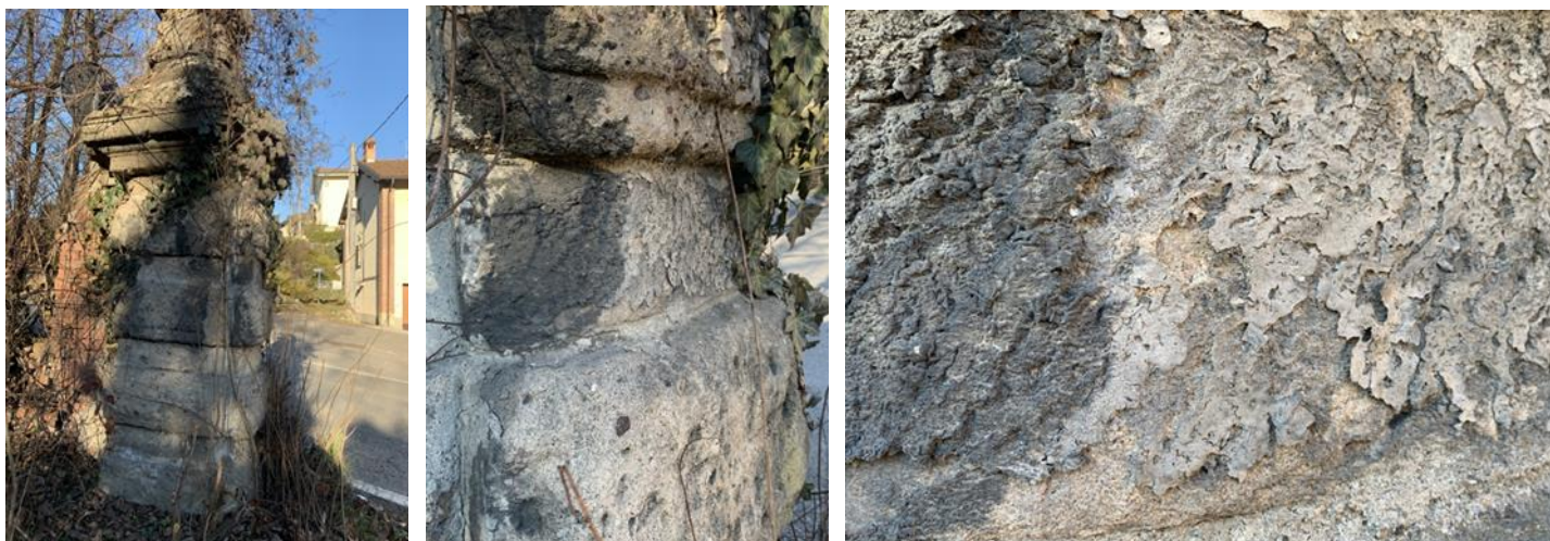
Figure 36, 37 e 38 – Croste nere e scagliatura
