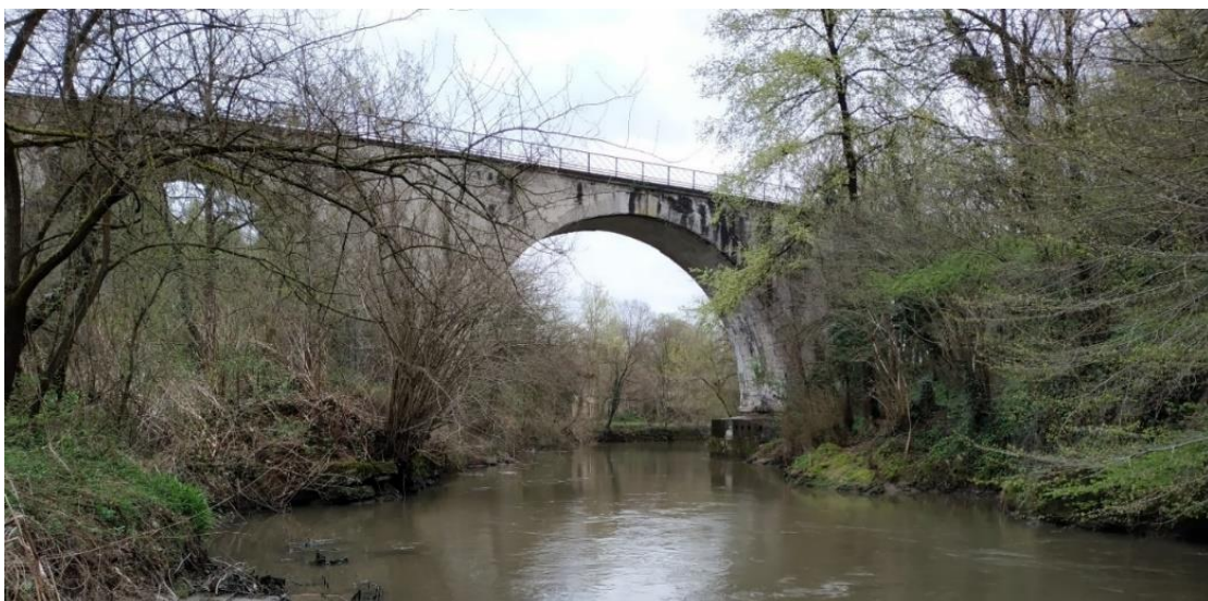
Figura 29 - ponte della ferrovia della linea Milano - Lecco, vista da monte
