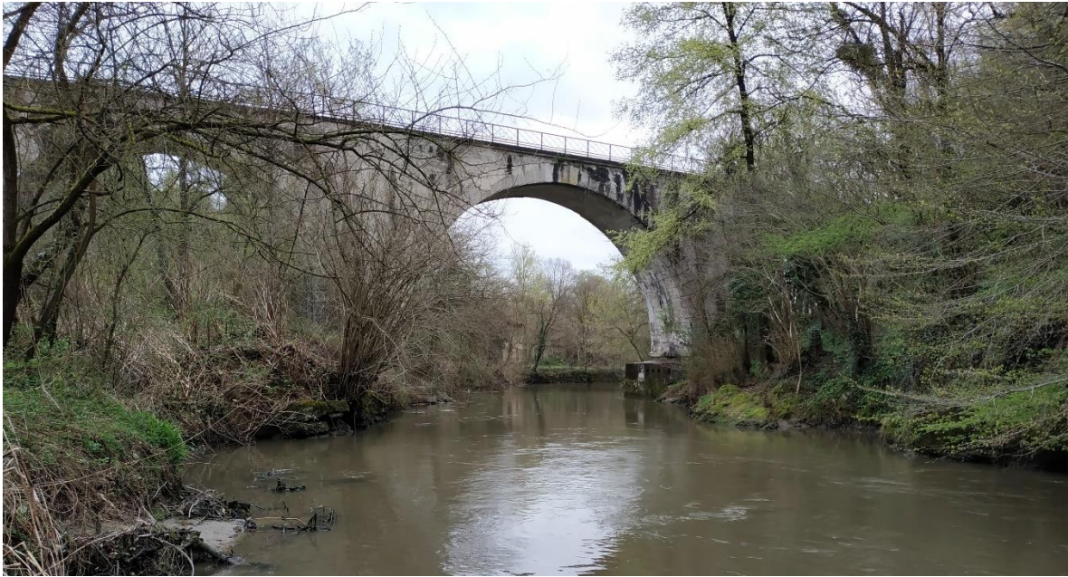
Figura 8: ponte della ferrovia della linea Milano - Lecco, vista da monte
