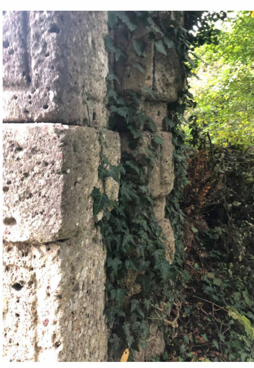
INGRESSO SCALINATA - ESISTENTE
