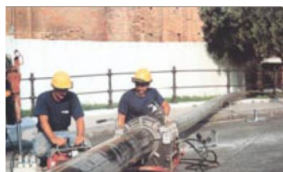
OPERAZIONI DI PIPE-COATING
